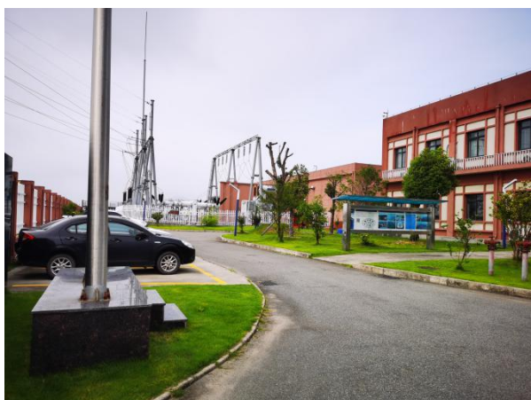
图 1-9 升压站内道路及排水
