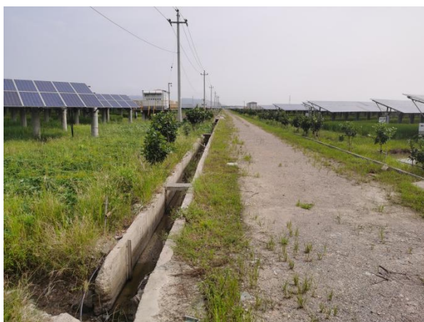
图 1-5 光伏场内道路排水沟
