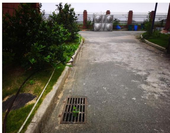
图 1-10 升压站内道路及排水
