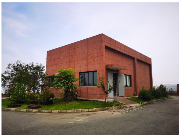
图 1-11 升压站内绿化
