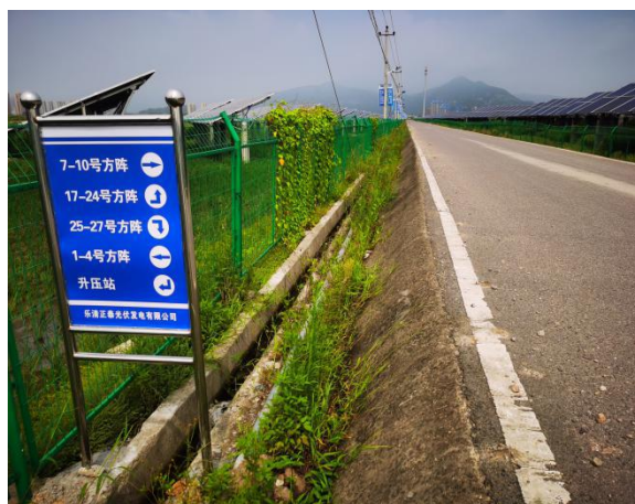
图 1-6 光伏场内道路排水沟
