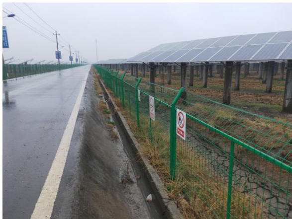
图 1-1 光伏区排水沟
